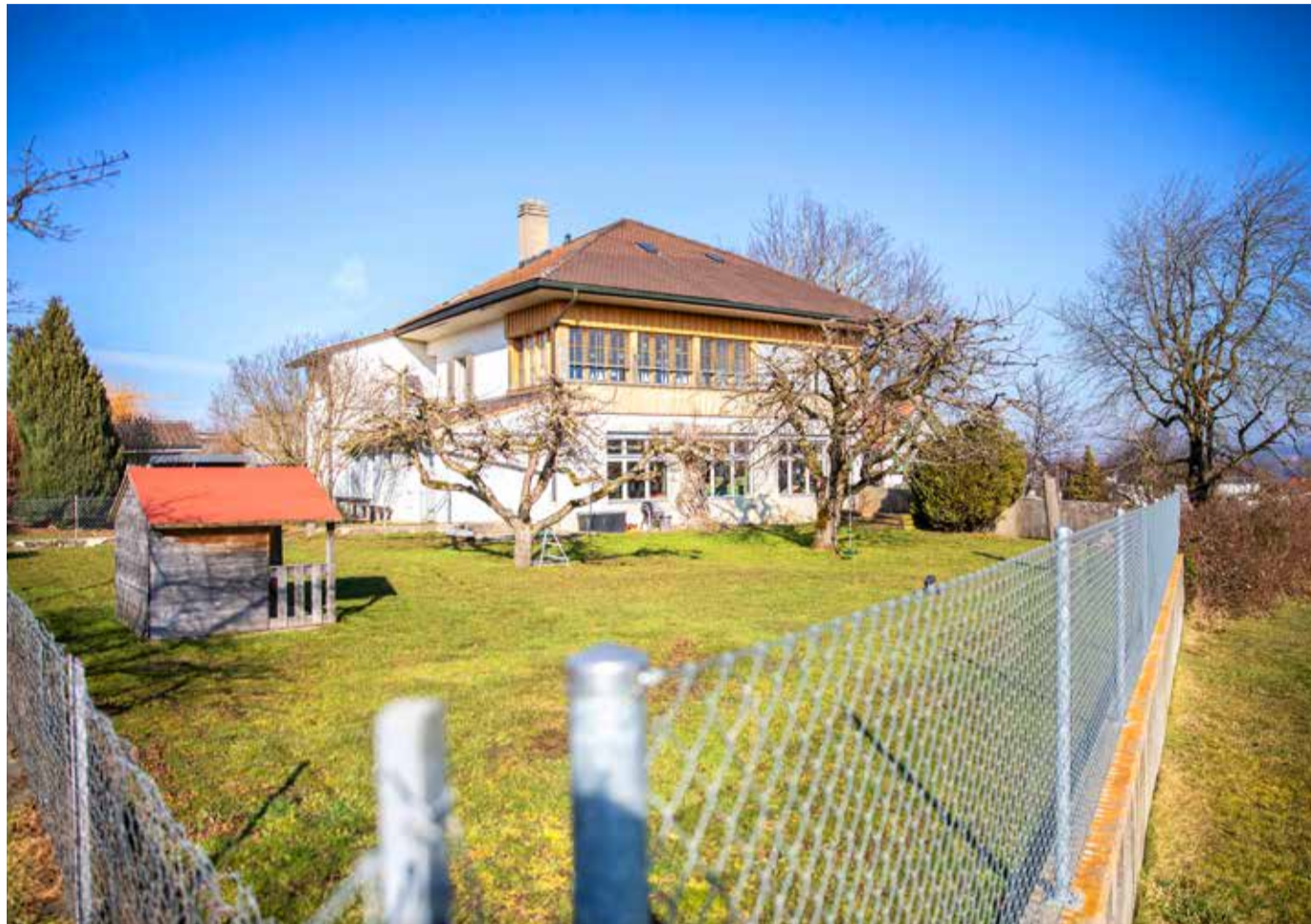
Das Schlössli Wünnewil ist sanierungsbedürftig. Darum soll der Generalrat einen Kredit sprechen.
